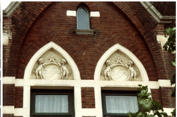
Rue des Deux Tours 111, les tympanons du 2e niveau (photo 1993-1995)
